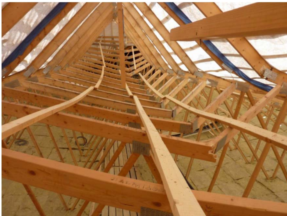
Figur 5 3 langsgående afstivninger på udknækkede hanebånd (Aulum)
